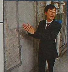
■彭瀚華指愛民邨安裝MPS後，其儲物室滲水情況大為改善。 黃建通攝
