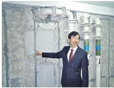
房屋署物業管理總經理（支援服務）彭瀚華表示，安裝了電滲透防水系統後，即使在黑雨的翌日，牆身都沒有濕。（周展鴻攝）
