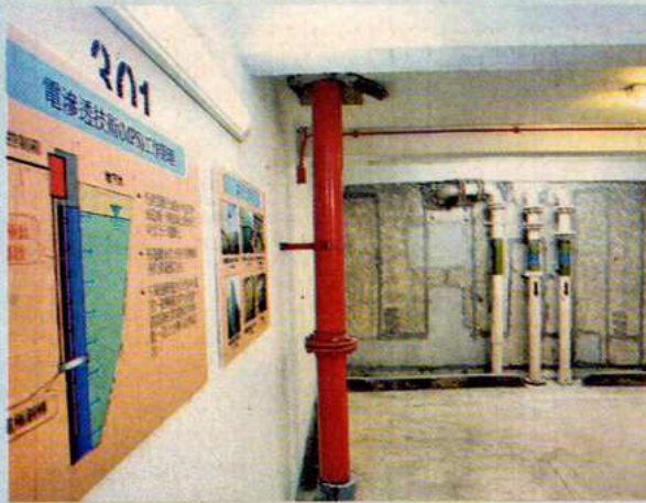
■電滲透技術的原理是將混凝土的水分子電離化，然後逼向負電極銅棒再引到牆外。（麥潤田攝）
